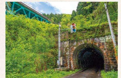
葉原トンネル
